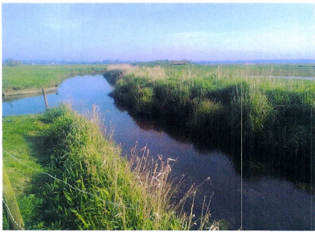
Photo n°1 : vue aval des travaux section 1 du ruisseau de la Plesse
